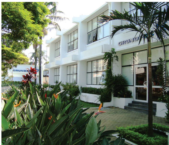
SEDE GRUNDFOS BRASIL São Bernardo do Campo – SP
