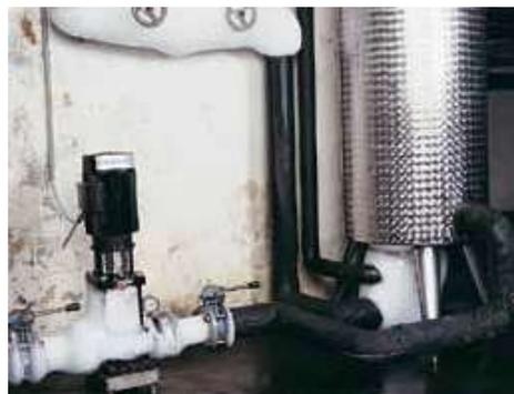
As bombas utilizadas em aplicações que envolvam o controle de temperatura são expostas a temperaturas muito baixas ou muito altas, bem como flutuações. Esta exposição a condições extremas estressam os materiais devido à expansão ou contração térmica.
